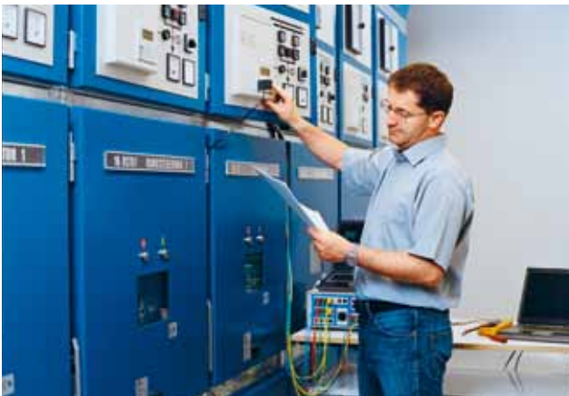
Schutzgeräte werden auf ihre Funktionalität geprüft.
